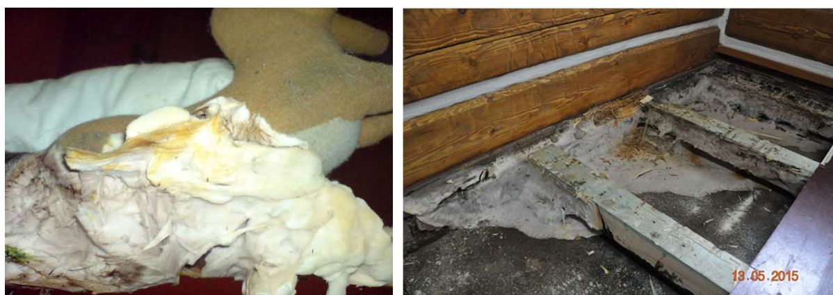
Obr. 44. Dřevomorka pojídající koníka a podlahu rekreační chalupy v Krkonoších.
