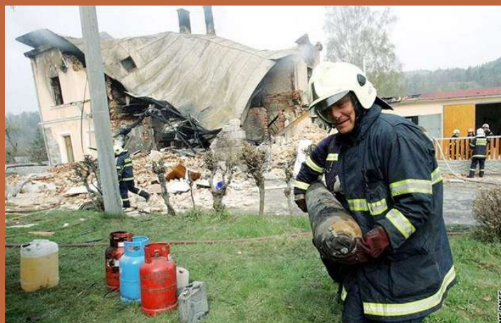
Důsledek nesprávného připojení tlakové lahve (propan-butan) k zařízení (trouba).
