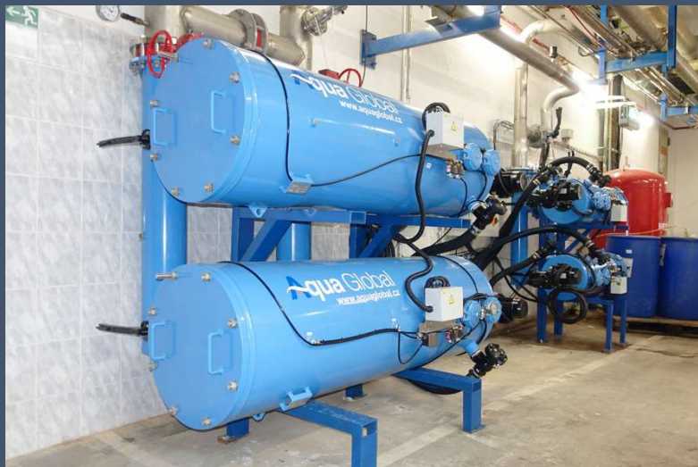
Filtrační vložky CJC řady B a BLA velikosti 15/25 a 27/27 pro CJC OFF-LINE obtokovou filtrací lubrikačních, hydraulických, turbínových, převodových, honovacích a válcovacích olejů
